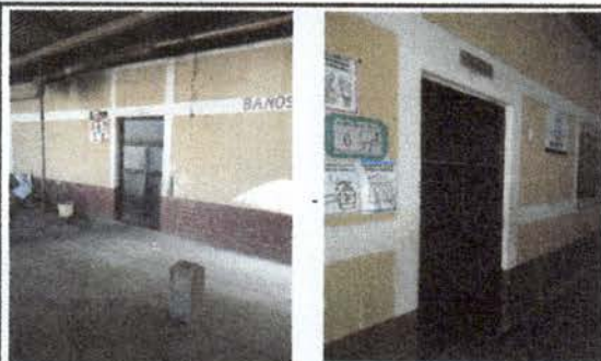
Foto 5: REPARACION DE PUERTA DE AULAS Y COCINA, POR LA COLOCACION DE PISO ES NECESARIO CORTAR LA PARTE INFERIOR DE LAS PUERTAS Y PINTADA.
