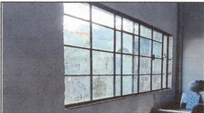
Foto 9: Elaboracion de ventana de corrediza 80x2.20 metro
