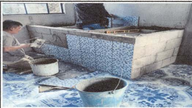
Foto 8: Fabricacion de pila para agua con 2 lavaderos de azulejo de 1.70 x 1 metro y de 0.80 metros de altura
