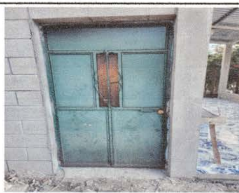
Foto 10: Mantenimiento de puertas con chapa yale 2x1metro
