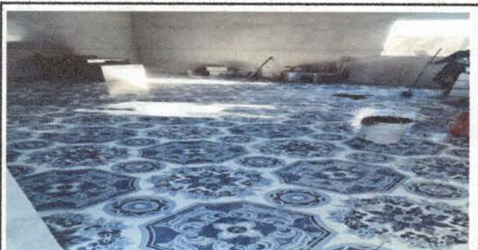
Foto 6: Sustitucion de piso de cocina con piso ceramico
