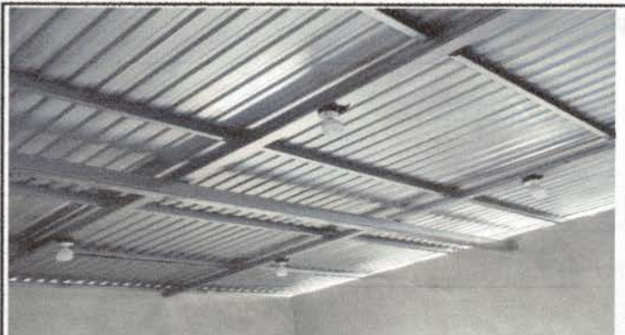
Foto 4: Viga principal de techo de 6x4
