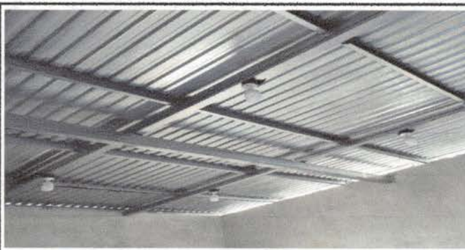
Foto 12: Sistema electrico instalacion de 20 metro cableado, intalacion de 10 lamparas, 20 toma corriente e intalacion de un tablero
