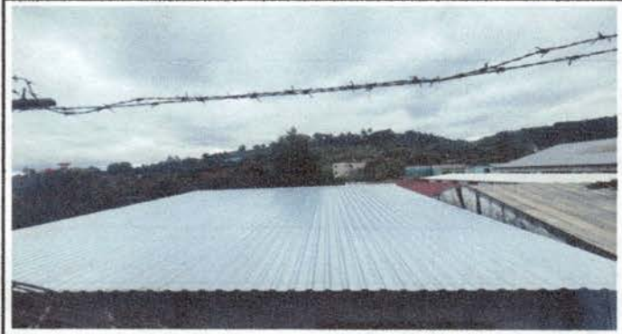
Foto2: Sustitución de techo de cocina con lamina Troquela Alucink calibre 26
