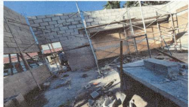
Foto 2: Sustitución de Techo de cocina con lamina Troquelada Alucink Calibre 26
