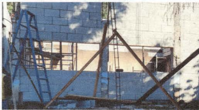
Foto 9: Elaboracion de ventana de corrediza 80x2.20 metro
