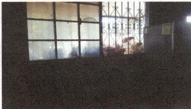
Foto 9: Elaboracion de ventana de corrediza 80x2.20 metro
