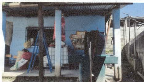
Foto 4: Viga principal de techo de 6x4
