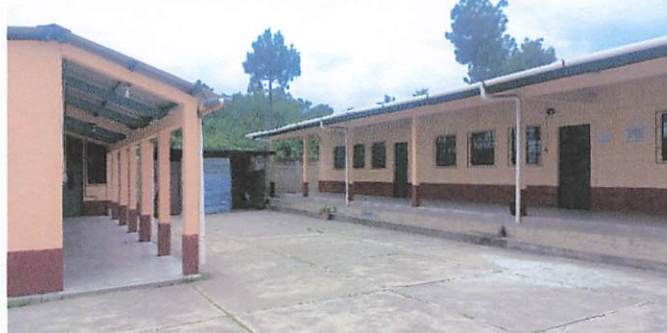
Foto 4: PINTURA INTERIOR Y EXTERIOR
