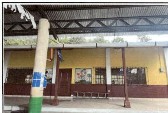
Foto 4: canales nuevos en corredor y tomacorriente nuevo.
