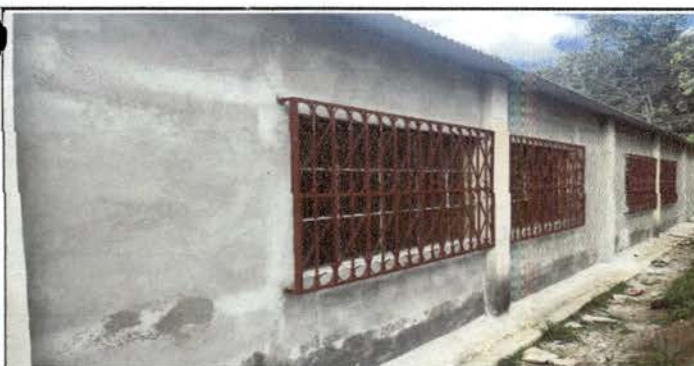
Foto 5: Balcones nuevo y cernido terminado en las 2 aulas y direccion.
