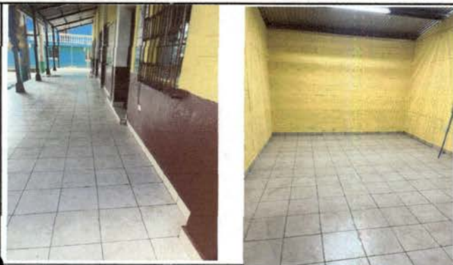
Foto 1: Piso cerámico nuevo en corredor de las 2 aulas e interior de dirección.
