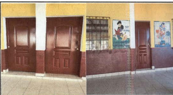
Foto 3: pintura nueva en las 2 aulas y dirección.
