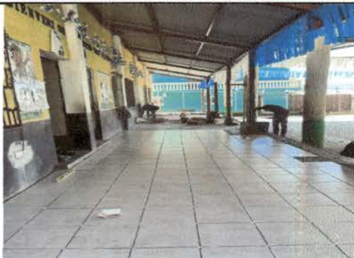
Foto1: proceso de instalación de piso cerámico en corredor salon de clase.
