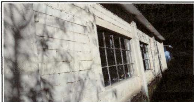
Foto 5: ES NECESARIO LA INSTACION DE BALCONES DE LAS 2 AULAS Y CERNIDO POR HUMEDAD.
