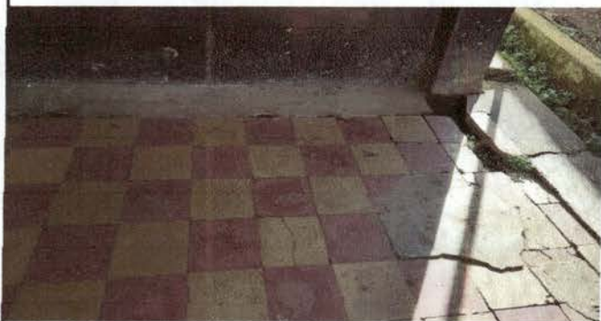
Foto 1: PISO DETERIORADO, ES NECESARIO CAMBIO DE PISO EN CORREDOR DE SALONES DE CLASES
