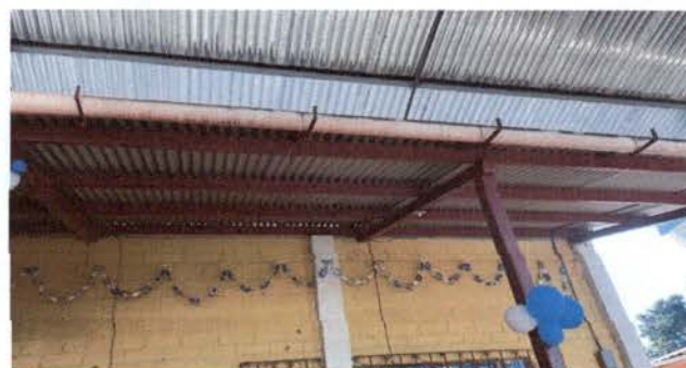
Foto 4: ES NECESARIO CAMBIO DE CANALES DETERIORADOS A CANALES NUEVOS.
