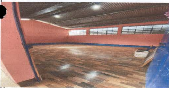
Foto 5: pintado de final interiores de aulas
