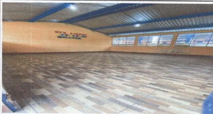
Foto1: finalización de azulejos en las aulas
