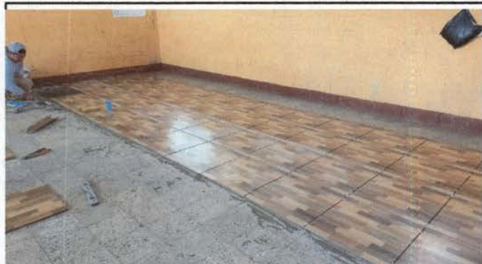
Foto1: colocación de azulejo en las aulas
