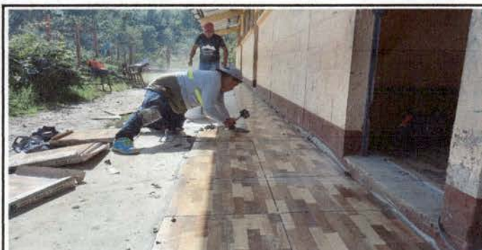
Foto 4: colocación de azulejos en corredor.
