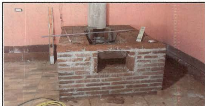
Foto 3: Construcción de plancha para cocinar
