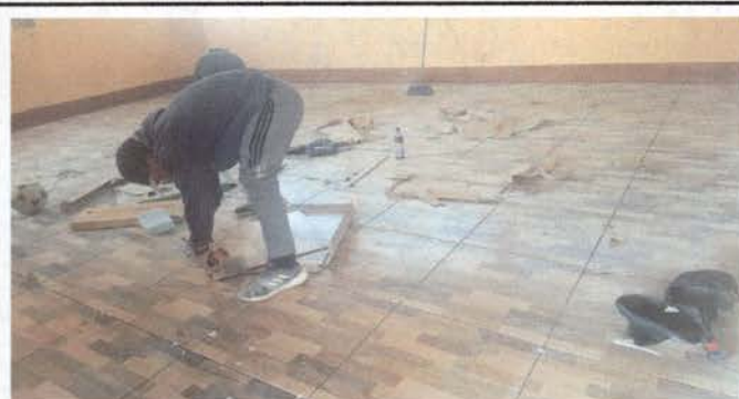
Foto 2: se muestra el proceso de colocación de azulejos en las aulas y zócalo
