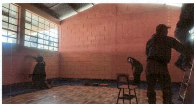
Foto 5: pintado de interior de aulas
