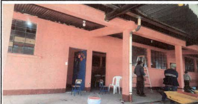
Foto 6: pintado de exterior de aulas.
