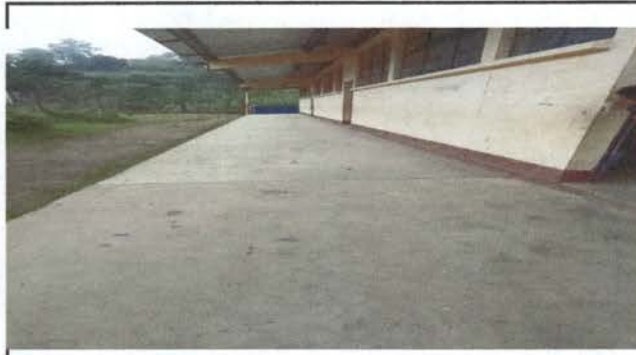
Foto 2: Piso del corredor de las aulas
