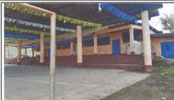
Foto7: Pintura del módulo 3
