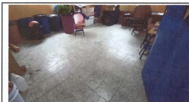
Foto 6: piso de la bodega
