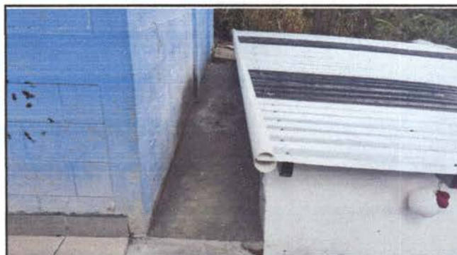
Foto 4: Mantenimiento de muro de contención.
