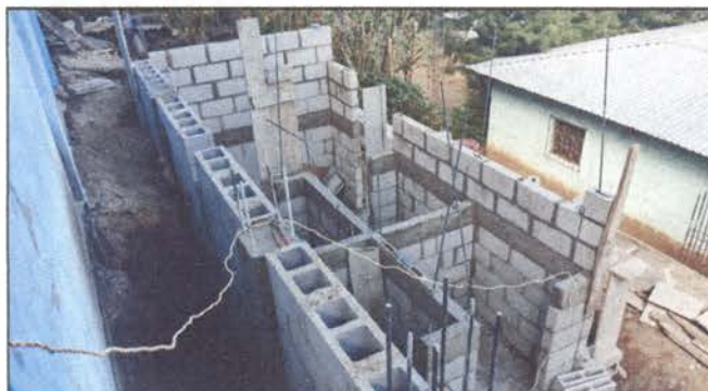
Foto 4: Mantenimiento de muro de contención.
