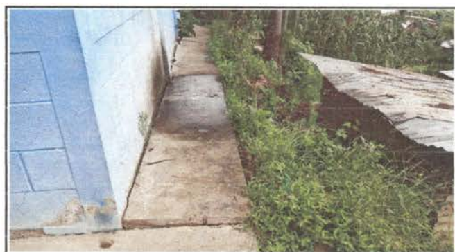
Foto 4: Mantenimiento de muro de contención.
