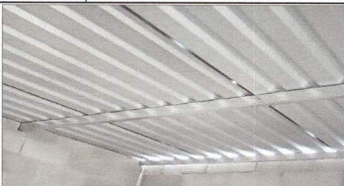
FOTO 8: CULMINACIÓN DEL TECHADO DE LA COCINA.
