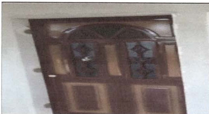
Foto 3: UNO DE LAS PUERTAS YA COLOCADAS
