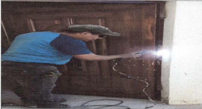
FOTO 7: COLOCACIÓN DE LAS NUEVAS PUERTAS
