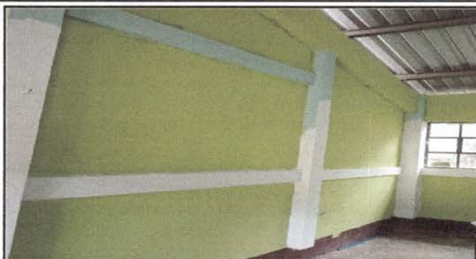
Foto 2: ÁREA DONDE SE ESTA PINTANDO LOS SALONES DE CLASES.
