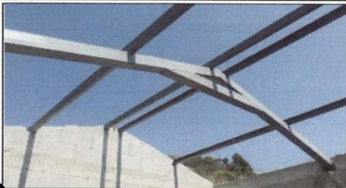
Foto1: EN EL MOMENTO QUE SE COLOCA LAS ESTRUCTURAS DE SOPORTE PARA LAS LAMINAS
