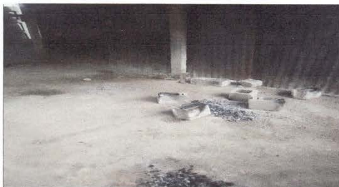
Foto 3: CONSTRUCCIÓN DE UNA ESTUFA DE COCINA
