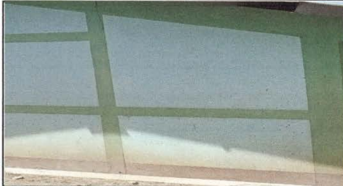
FOTO 7: PINTURA EN PAREDES DETARIORADAS, ES NECESARIO EL MANTENIMIENTO DE SALONES CON PINTURA NUEVA.
