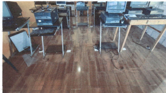
Foto 4: Instalación de energía
