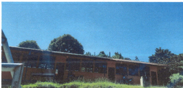
Foto 5: Aplicación de pintura
