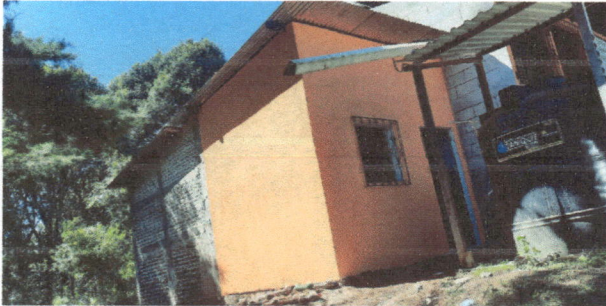
Foto1: Ampliación de cocina
