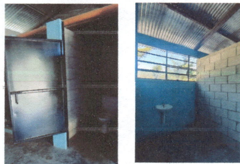
Foto 2: Reparación de sanitarios y migitorios
