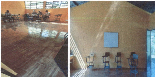
Foto 3: Instalación de piso
