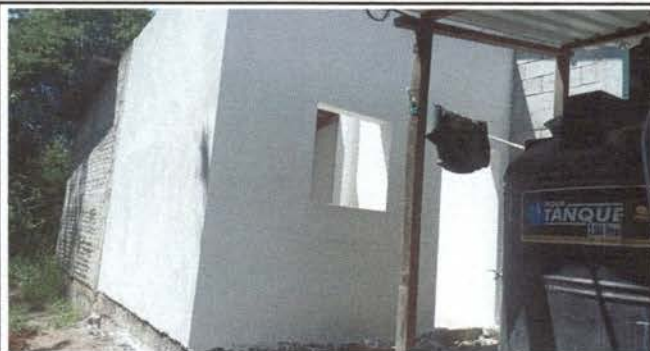
Foto 1: Ampliación de Cocina
