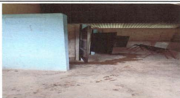
Foto 2: Reparación de sanitarios y Migitorios
