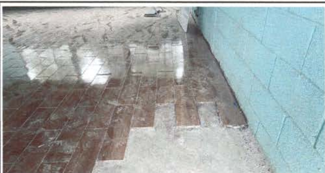
Foto 3: Instalación de Piso
