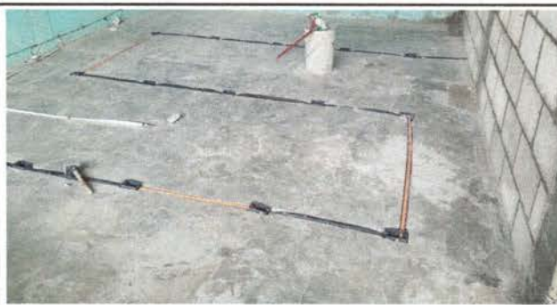
Foto 4: Instalación de energía Eléctrica
