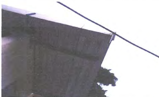
Foto 3: cambio de una lámina en el techo de la cocina y reparación de cargador de canal.
