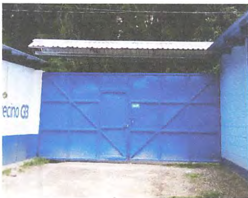
Foto 7: techo sobre portón principal del establecimiento
