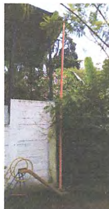
Foto 8: canal en techo del segundo nivel en bajada de gradas
