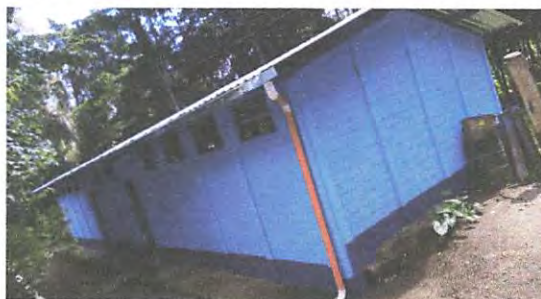
Foto 6: cambio de 137m² de lámina de techo, cambio de canal para bajada de agua y mantenimiento y pintura de costanera
