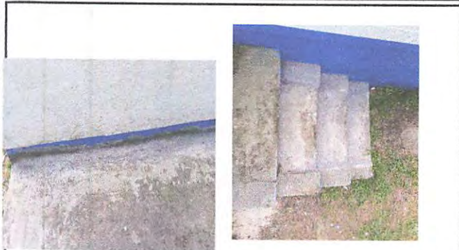
Foto1: reparación de filtraciones en escenario y gradas
