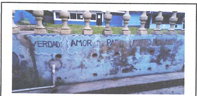
Foto 5: reparación de muro en gradas a un costado de la dirección
