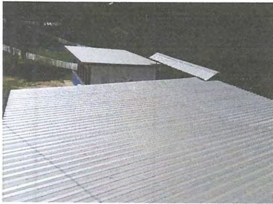
Foto 7: cambio de 76m 2 de techo de un salón, cambio de canal para bajada de agua y mantenimiento de costaneras.
