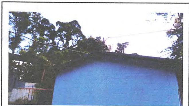
Foto 3: levantar e instalar poliducto en cables de patio
