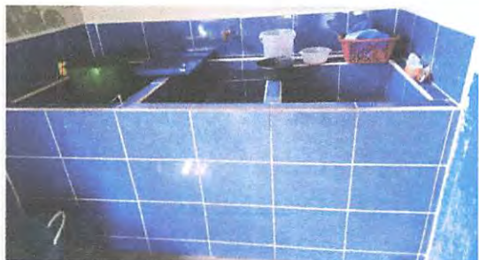
Foto 1: apertura de pila dentro de cocina con cerámica
