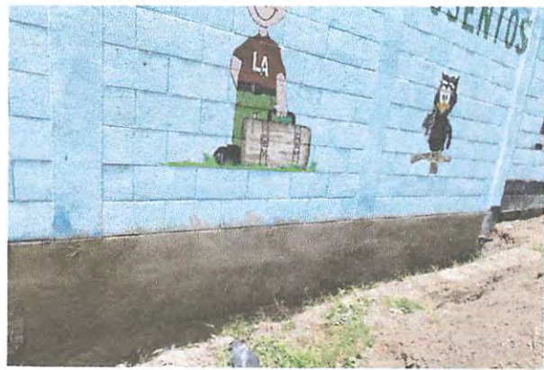
Foto 8: repello de 30.5m x 1m pared para evitar la filtración de humedad y moho
