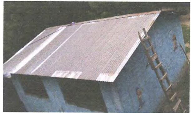
Foto 10: cambio de 43m 2 de techo (sólo se pagará la quitada y puesta, se reutilizará lámina que ya se tiene en posesión).
