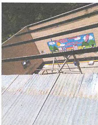
Foto 7: cambio de 76m 2 de techo de un salón, cambio de canal para bajada de agua y mantenimiento de costaneras.
