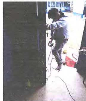
Foto 4: cambio de 3 chapas en puertas
