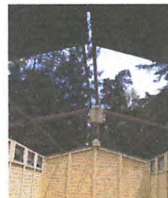
Foto 6: cambio de 137m² de lámina de techo, cambio de canal para bajada de agua y mantenimiento y pintura de costanera
