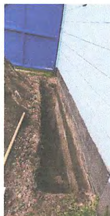
Foto 8: repello de 30.5m x 1m pared para evitar la filtración de humedad y moho
