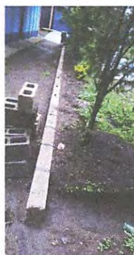
Foto 10: Reparación de jardinera (mano de obra sin costo)
