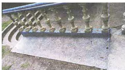
Foto 5: reparación de muro en gradas a un costado de la dirección
