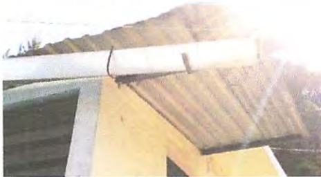
Foto 3: cambio de una lámina en el techo de la cocina y reparación de cargador de canal.
