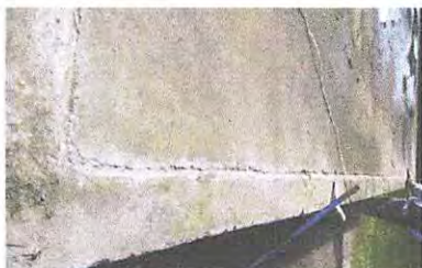
Foto 1: reparación de filtraciones en escenario y gradas
