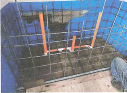
Foto 1: apertura de pila dentro de cocina con cerámica
