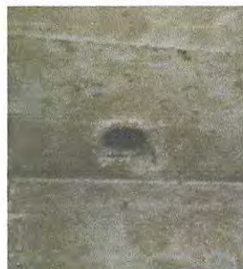
Foto 2: sellado de agujero en chimenea de cocina
