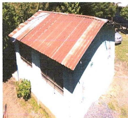
Foto 10: cambio de 43m 2 de techo (sólo se pagará la quitada y puesta, se reutilizará lámina que ya se tiene en posesión).
