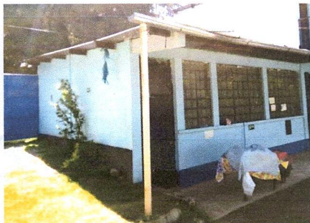
Foto 7: cambio de 76m 2 de techo de un salón, cambio de canal para bajada de agua y mantenimiento de costaneras.
