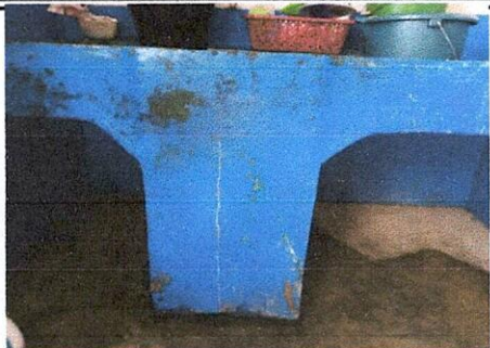
Foto 1: apertura de pila dentro de cocina con cerámica
