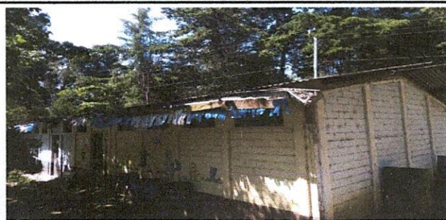
Foto 6: cambio de 137m² de lámina de techo, cambio de canal para bajada de agua y mantenimiento y pintura de costanera
