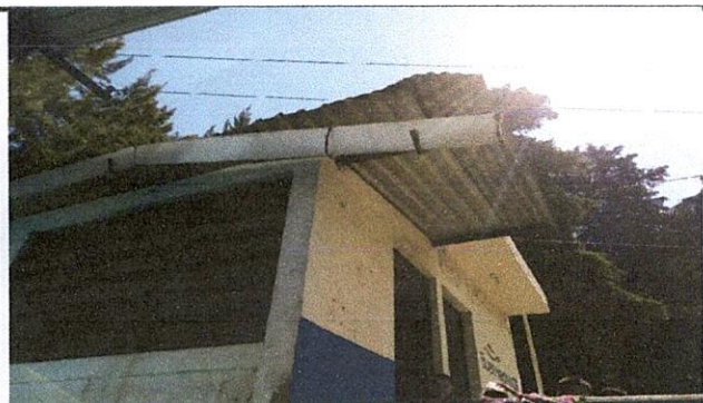
Foto 3: cambio de una lámina en el techo de la cocina y reparación de cargador de canal.
