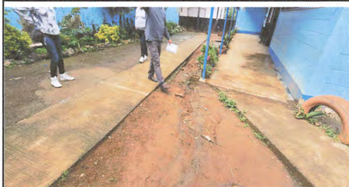
Foto 4: Ampliar de Pavimento
