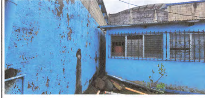
Foto 6: Creacion de Sanitarios
