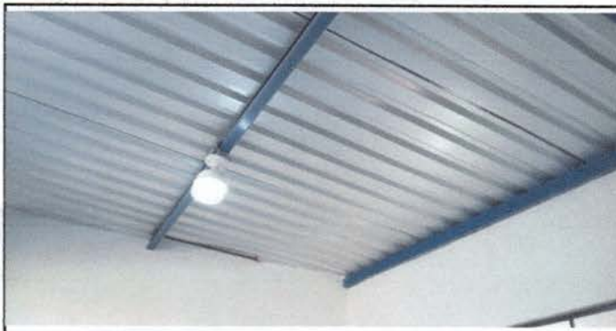
Foto 3: cocina: colocacion de techado, terminado y energia electrica
