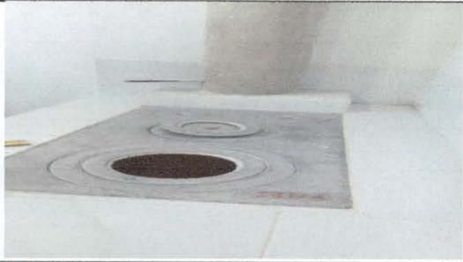
Foto1: COCINA: POLLETON TERMINADO
