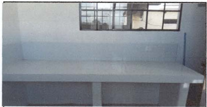
ventanas instaladas y mesa de concreto terminada
