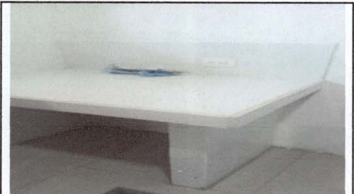
Foto 2: COCINA: mesas de concreto, terminadas
