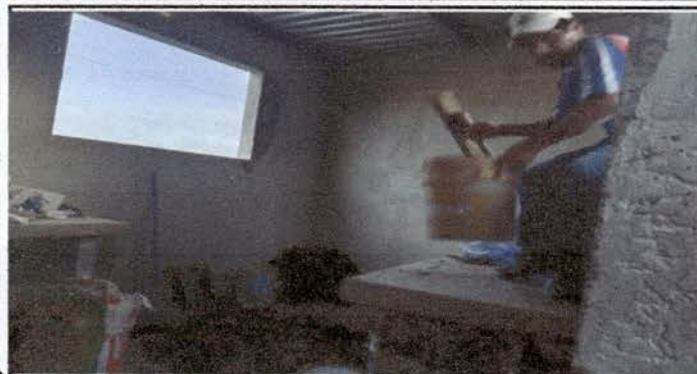
Foto1: colocacion de repello gris en muros de cocina
