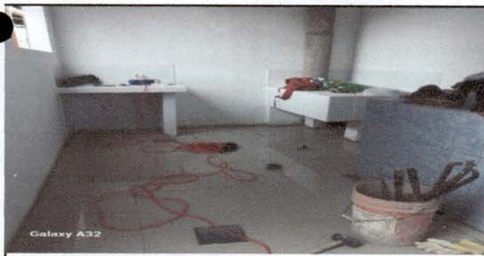
colocacion de piso, azulejo en mesas de concreto y pila
