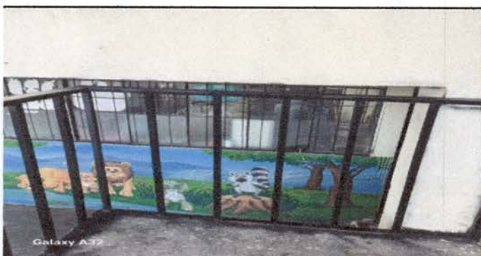
mantenimiento y pintados de barandas
