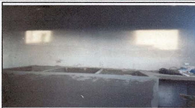
Elaboracion de pileta en cocina
