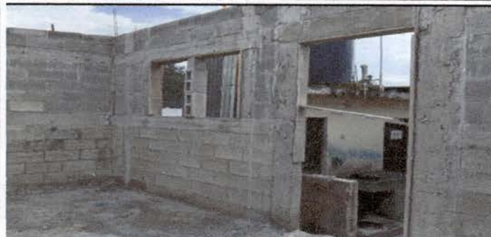
Foto1: COCINA: Instalacion de puertas y ventanas, instalacion de electricidad
