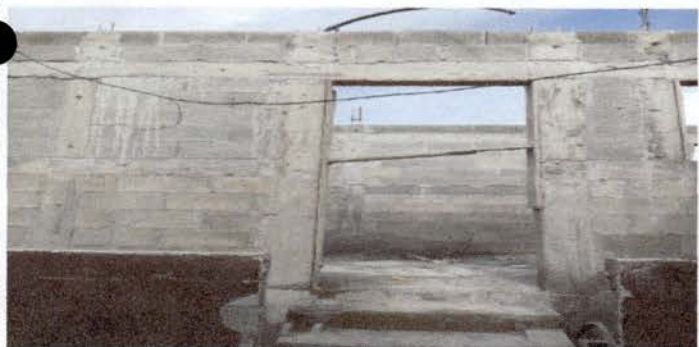
COCINA: Instalacion de canales,
