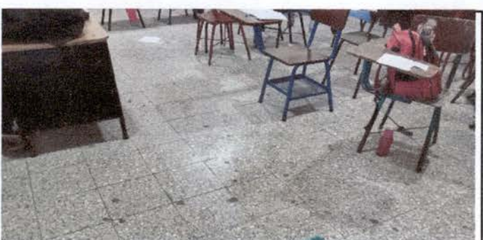
AULA: Colocacion de piso ceramico.
