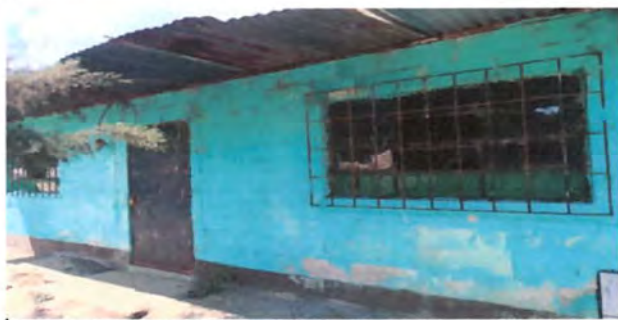
Foto 9: PUERTA DE METAL EN MAL ESTADO Y MUROS CON MARCAS DE HUMEDAD
