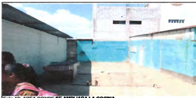
Foto 12: AREA DONDE SE AMPLIARA LA COCINA
