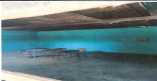
Foto 7: VISTA INTERIOR DE COCINA
