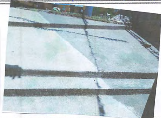
Foto 7: Patio: Nivelación entrada Principal.
