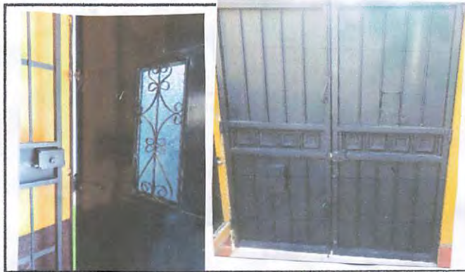
Foto 19: Pintura de puertas y portón color negro anticorrosivo.
