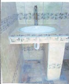
Foto 4: Lavamanos - en Sanitario de maestras, y drenaje.
