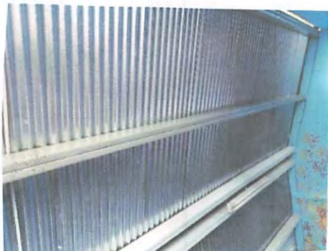
Foto 1: Colocación de lámina en un aula.
