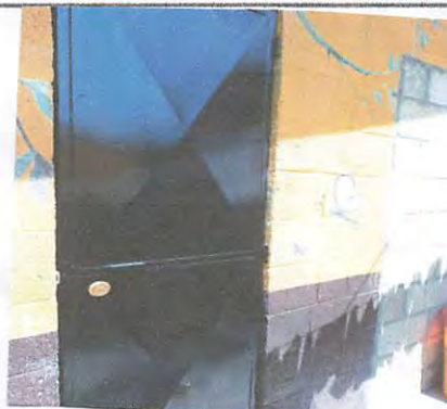
Foto 2: Ampliación, Anulación de puerta con un metro de levantado de Pared, repello.
