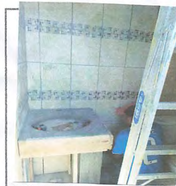
Foto 4: Colocación de un lavamanos en sanitario de maestras, y drenaje.
