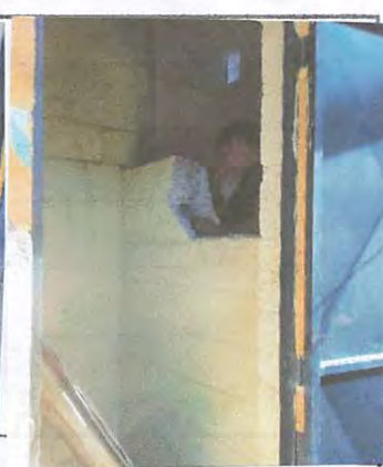
Foto2: Anulación de puerta con un metro de levantado.
