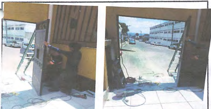
Foto 17: Fabricación e Instalación para Puerta entrada Principal
