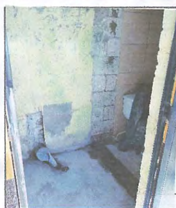
Foto2: Anulación de puerta con un metro de levantado.
