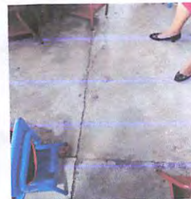
Foto 6: Piso: En el aula la torta se esta agrietando y esta undida en algunas partes se fundira nuevamente y se colocara piso ceramico anti deslizante.
