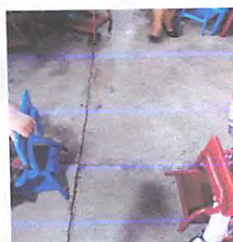
Foto 6: Piso: En el aula la torta se esta agrietando y esta undida en algunas partes se fundira nuevamente y se colocara piso ceramico anti deslizante.
