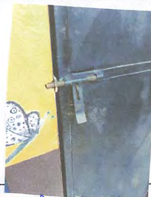
Foto 19: Pintura de Puertas y Porton
