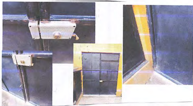
Foto 17: Porton: se traba la llave, se ha cambiado la chapa de veces esta en mal estado
