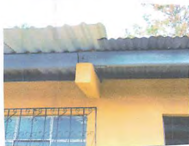
Foto 1: Laminas: cambio de techo en un aula, por encontrarse muy deteriorada.
