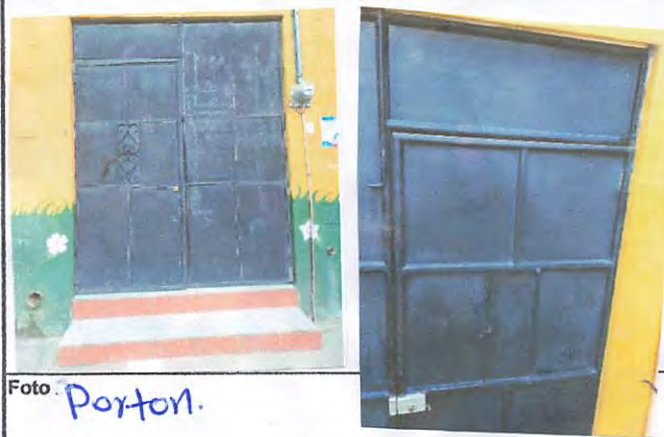
Foto 17: Porton: se traba la llave, se ha cambiado la chapa de veces esta en mal estado
