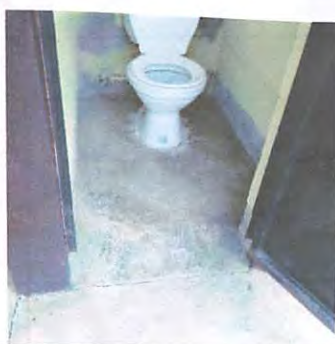
Foto 3: Piso: El piso en el sanitario de maestras se encuentra ya muy deteriorado ya que es torta.
