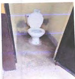
Foto 5: Taza de baño: Se cambiara por motivo que ya se encuentra en mal estado.
