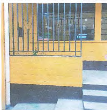
Foto 10: Demolición de torta y fundición en entrada Principal.
