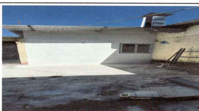
Foto 4: Instalacion de laminas en cocina
