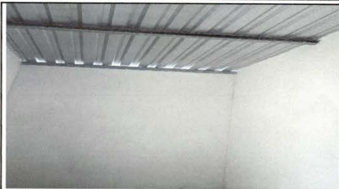
Foto1: Ampliacion de Cocina
