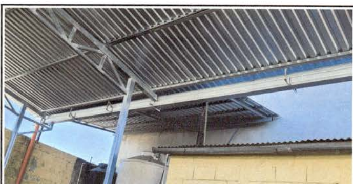
Foto 6: Canales para cancha
