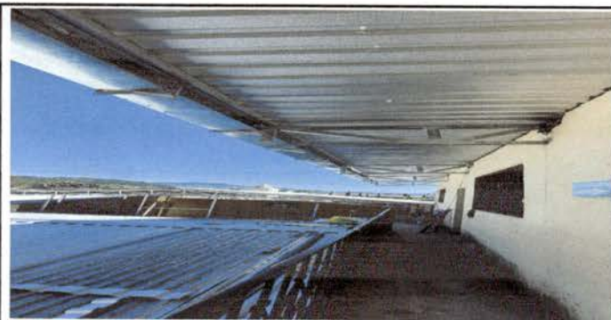
Foto 5: Ampliacion de Techado en el segundo Nivel
