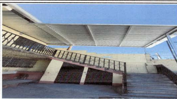
Foto 2: Techado de Laminas
