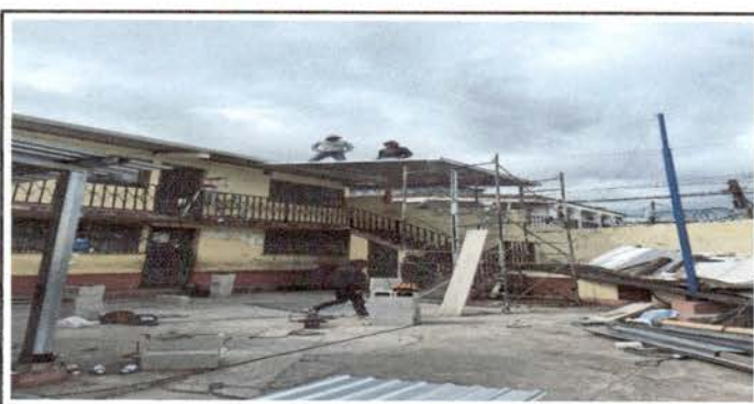
Foto 6: Ampliacion de Techo en gradas
