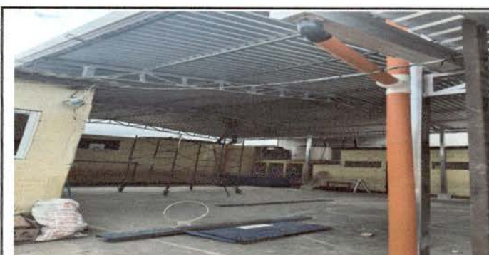
Foto 4: Instalacion de Lamina en techo
