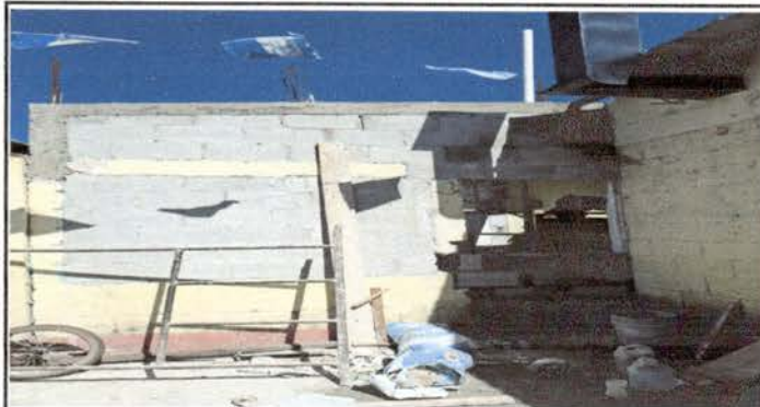
Foto 1: Ampliacion de cocina
