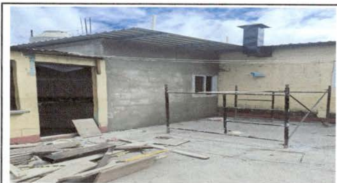
Foto 5: Ampliacion de Cocina
