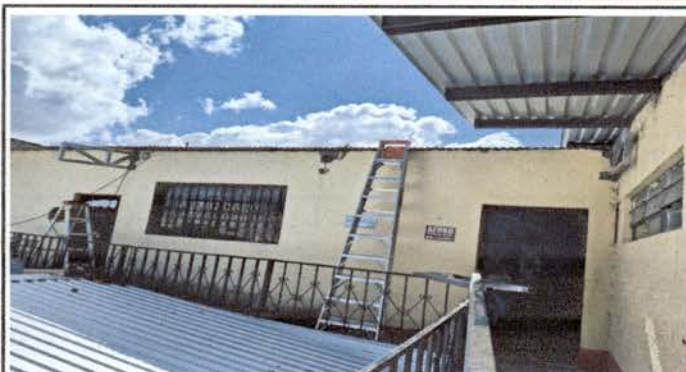
Foto 2: Ampliacion de Techo en Corredor
