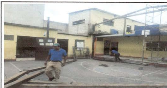
Foto 3: Desmontaje de techado
