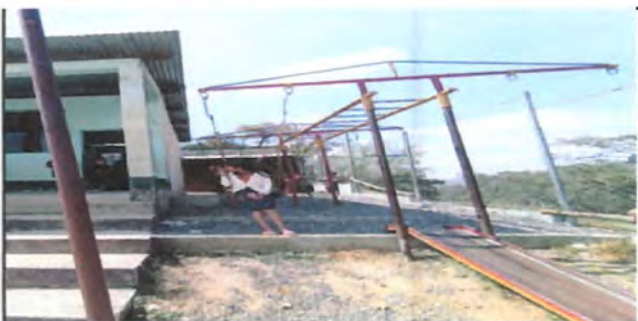
Foto 10: ÁREA DONDE SE IMPLEMENTARÁ ESTRUCTURA METÁLICA Y LAMINA TROQUELADA
