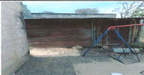
Foto 7: MURO DE LAMINA PORTANTE CON CORROSIÓN PISO DE TIERRA Y PUERTA DE LAMINA CON OXIDO
