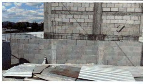
Foto 4: ELABORACIÓN DE MURO PERIMETRAL
