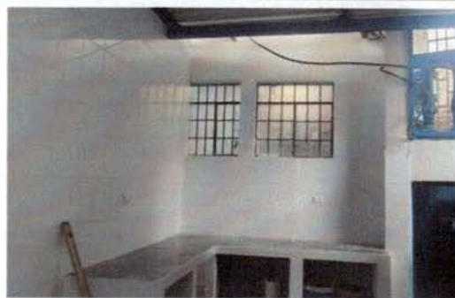
Foto 6: CONTRUCCION MUEBLE FIJO ÁREA DE COCINA
