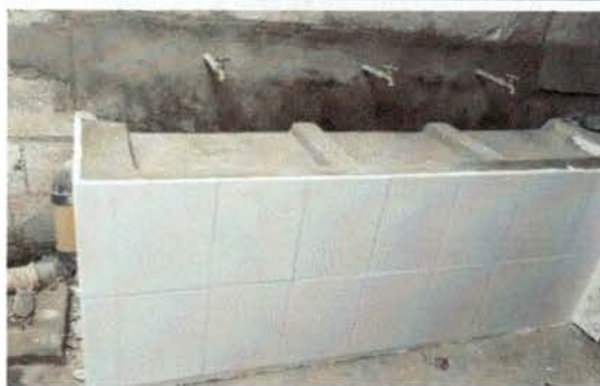
Foto 3: ELABORACIÓN DE PILETAS
