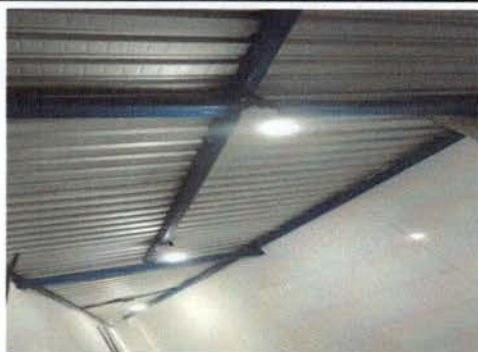
Foto1: TECHADO ÁREA DE COCINA
