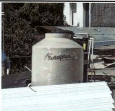
Foto 7: INSTALACIÓN DE CISTERNA
