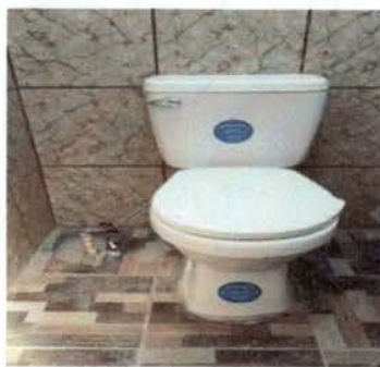
Foto 5: CAMBIO DE SANITARIOS
