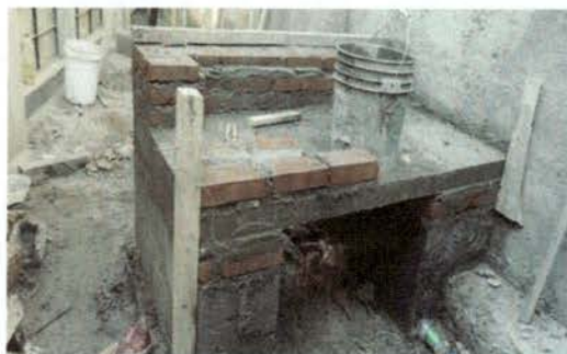
Foto 2: CONSTRUCCIÓN DE POYO
