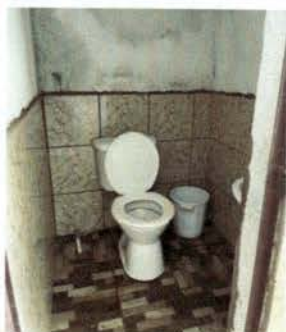
Foto 5: CAMBIO DE SANITARIOS
