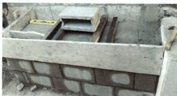
Foto 3: ELABORACIÓN DE PILETAS
