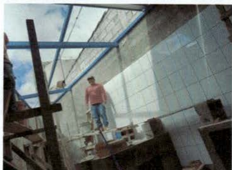
Foto1: TECHADO ÁREA DE COCINA
