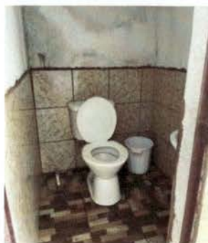
Foto 5: CAMBIO DE SANITARIOS
