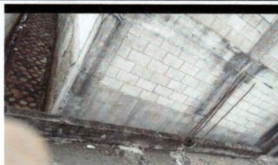
Foto 4: ELABORACIÓN DE MURO PERIMETRAL
