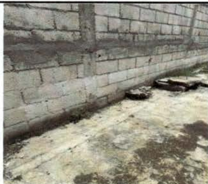
Foto 3: ELABORACIÓN DE PILETAS
