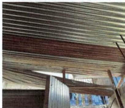
Foto 1: TECHADO ÁREA DE COCINA
