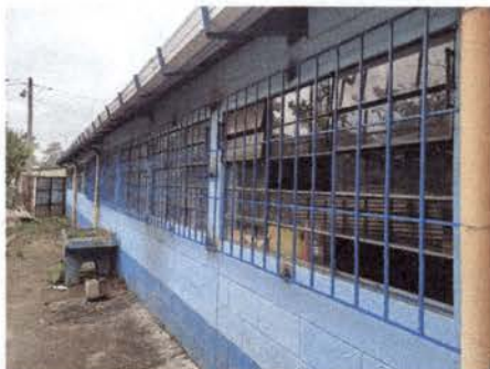
Foto 3: Colocación y terminación de balcones en los salones
