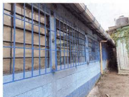
Foto 6: Instalación de balcones en ventanas de los salones
