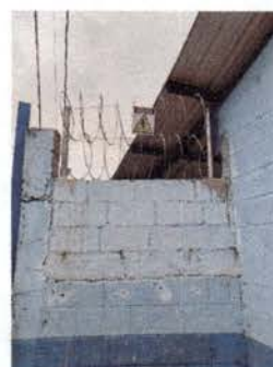
Foto 4: Instalacion de rotulo de prevención
