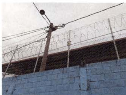
Foto 5: Instalación de Maya con alambre razor con electircidad
