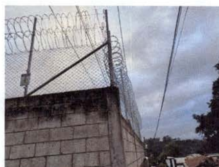
Foto 6: Instalación de Maya con alambre razor con electircidad parte de atrás del instituto
