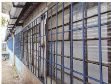
Foto 5: Instalación de Balcones en ventanas
