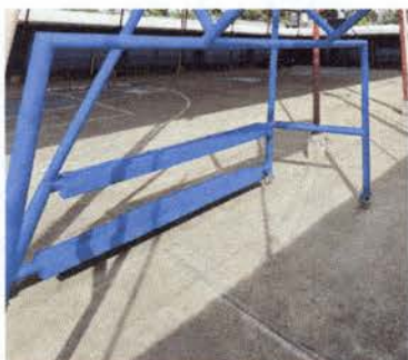
Foto 5: Reparación de porterías
