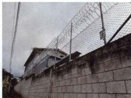
Foto 9: Instalación de Maya con alambre razor con electircidad
