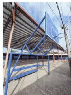
Foto 4: Reparación de porterías
