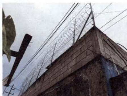
Foto 8: Instalación de Maya con alambre razor con electircidad
