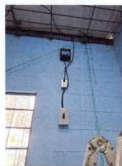
Foto 12: Instalación de caja y breaker de electricidad
