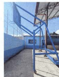
Foto 6: Reparación de porterías
