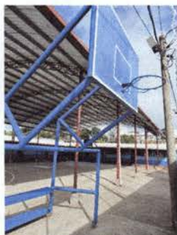
Foto 3: Reparación de porterías
