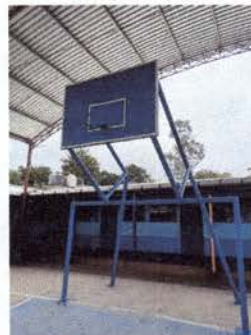
Foto 2: Reparación de porterías
