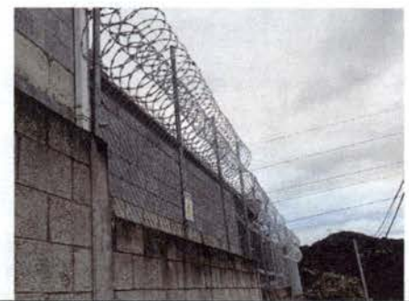
Foto 11: Instalación de Maya con alambre razor con electircidad en la parte de atrás del instituto
