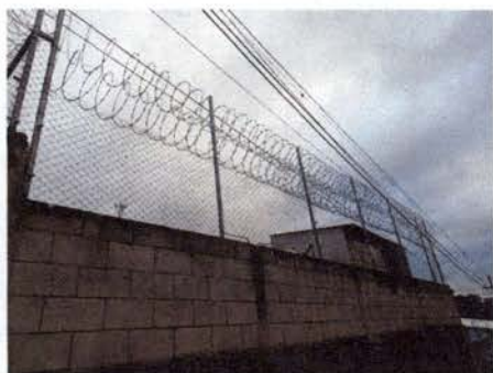
Foto 7: Instalación de Maya con alambre razor con electircidad
