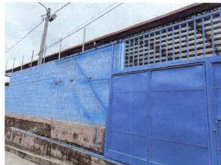
Foto 2: Terminación de colocación de reja.
