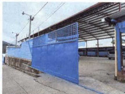
Foto 3: Terminación de guía principal con rodos
