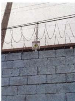
Foto 3: Instalacion de rotulo de prevención
