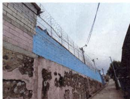
Foto 2: Instalación de Maya con alambre razor con electircidad
