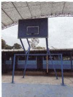
Foto 1: Reparación de porterías
