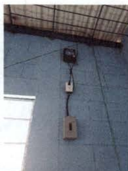
Foto 15: Instalación de breaker y caja general.
