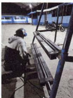
Foto 3: Instalación de contra peso
