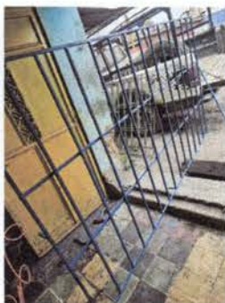
Foto 1: Elaboración de balcón en el taller del proveedor
