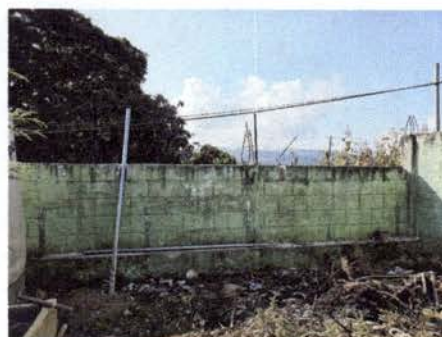
Foto 2: Colocación de tubos parte de atrás
