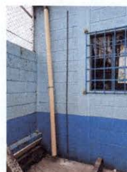
Foto 16: Instalación de barilla de cobre
