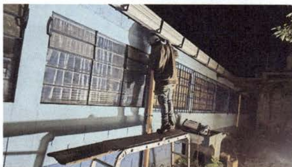
Foto 5: Intalación de Balcones en las ventanas
