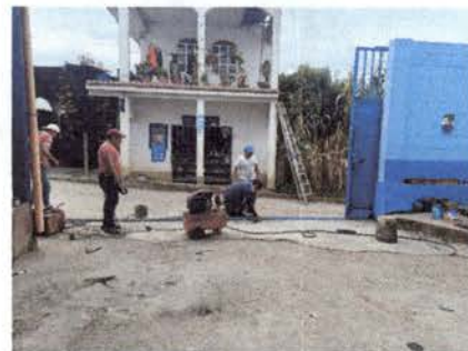
Foto 6: Reparación de riel del porton
