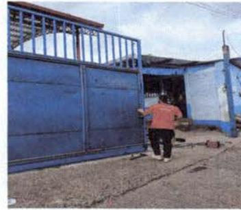
Foto 2: Reparacion de riel del porton
