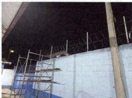
Foto 11: Instalación de razor
