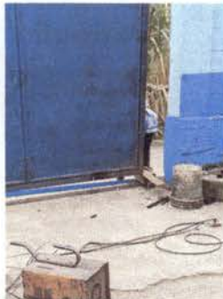
Foto 3: Cambio de guia principal
