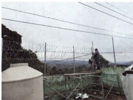
Foto 9: Instalación de razor
