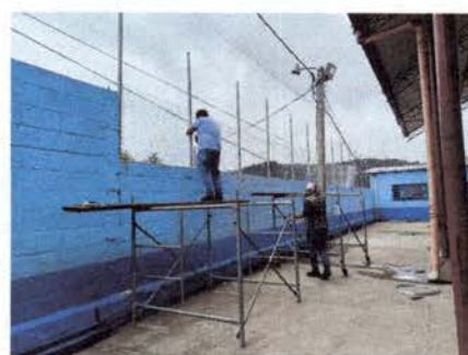
Foto 6: Instalación de maya
