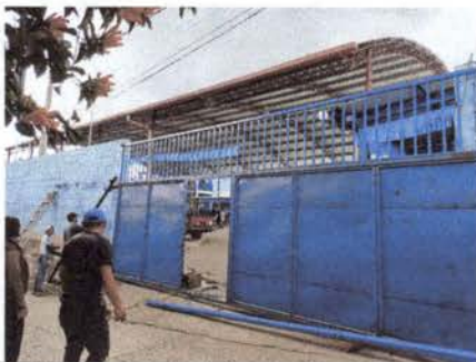
Foto 3: Colocación de guia principal con rodos
