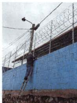
Foto 13: Instalación de alambre para corriente eléctrica
