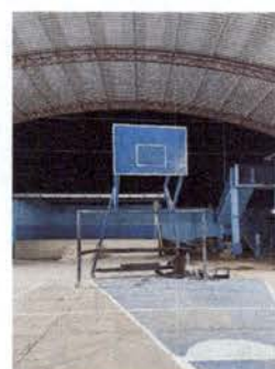
Foto 4: Reparación de porterías
