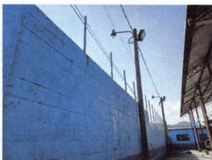
Foto 5: Instalación de tubos para maya
