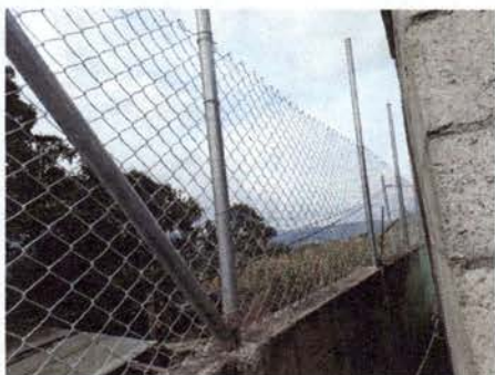
Foto 7: Instalación de maya parte de atrás
