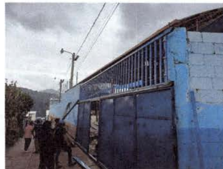
Foto 4: Colocación de reja superior
