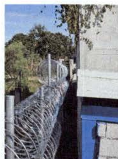
Foto 12: Instalación de razor parte de atrás
