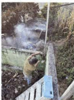
Foto 3: Fundición de tubos para maya
