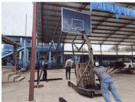
Foto 1: Reparación de porterías
