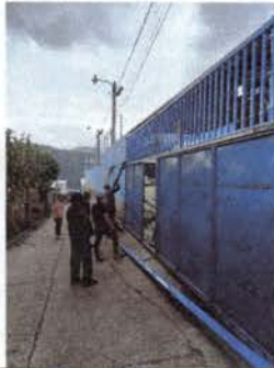
Foto1: Reparación de porton principal
