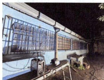
Foto 6: Instalación de balcones en ventanas
