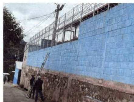
Foto 14: Colocación de aisladores de porcelana
