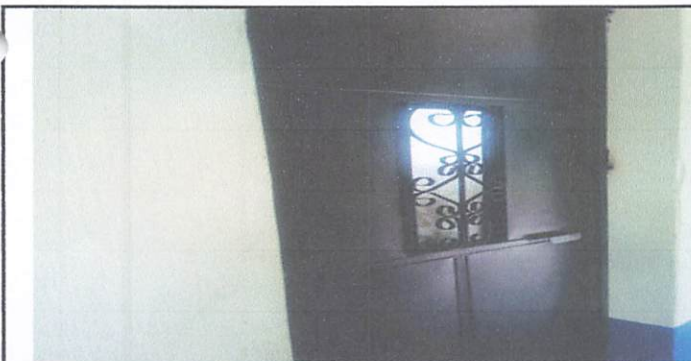
Foto 5: Puerta de acceso, instalada.
