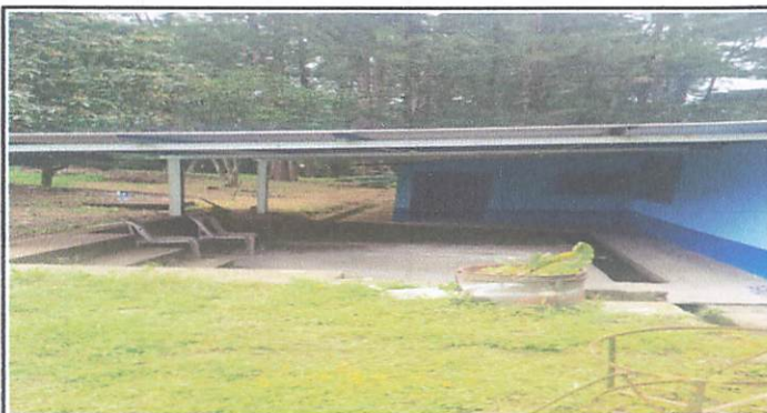
Foto 3: Techado de corredor de aula, estructura metálica portante y lámina acanalada.
