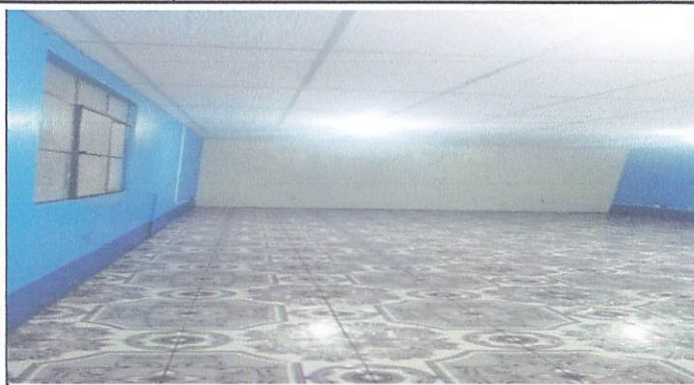
Foto 2: Pintura interior, piso cerámico, cielo falso, iluminación e instalación eléctrica (fuerza)
