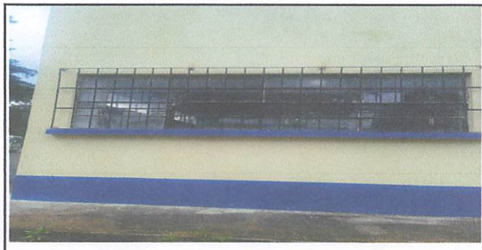
Foto 6: Balcones metálicos instalados.
