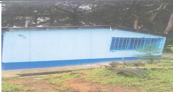
Foto 1: Aula pintada (vista exterior) con ventana y balcón instalado
