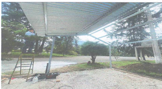
Foto 4: Estructura portante e instalación de techo de lámina en corredor frente a cocina.
