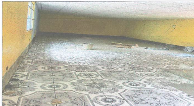
Foto 2: Proceo de instalación de piso cerámico en el aula.
