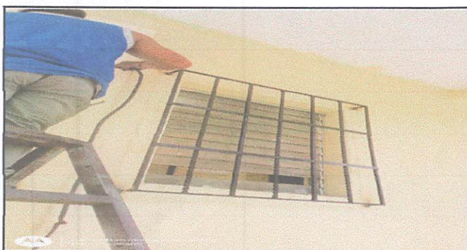
Foto 5: Instalación de balcones de metal
