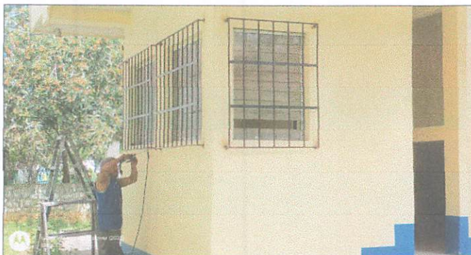
Foto 3: Instalación de balcones metálicos
