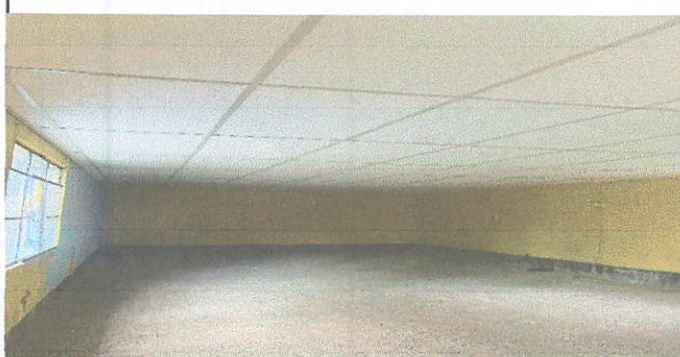
Foto1: Cielo falso instalado, tipo duroport
