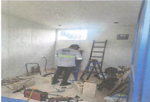
Foto13: Instalación de valcones en área de cisterna
