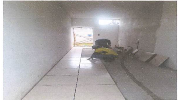
Foto 4: Instalación de piso en área de bodega
