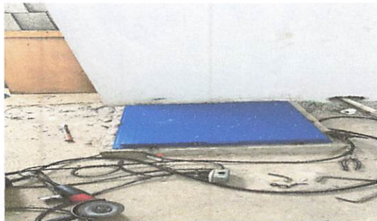
Foto7: Instalación de tapadera en cisterna
