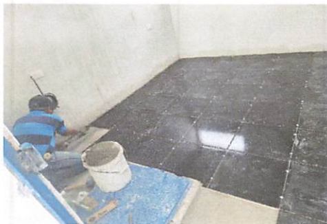
Foto 5: Instalación de piso en área de cisterna
