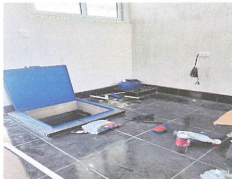
Foto 8: Instalación de bomba en agua en área de cisterna
