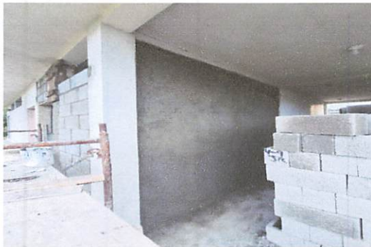
Foto 3: Levantado de muro y cernido en área de para bodega
