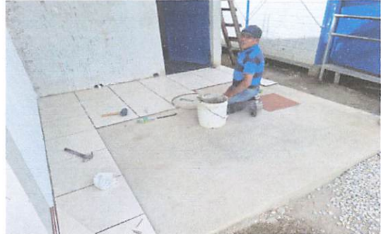
Foto 14: Instalación de piso en pasillo de cisterna
