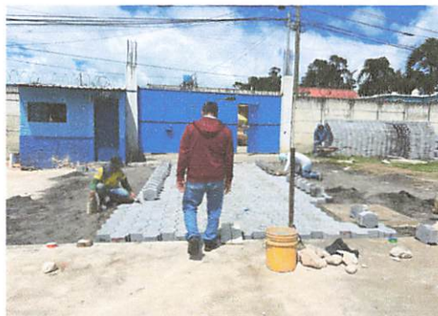
Foto 10: Instalación de adoquín en la entrada principal a preprimaria
