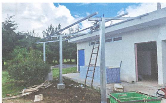
Foto 9: Techado de pila en frontispicio de batería de sanitarios
