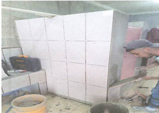
Foto1: Instalación de azulejo en en batería de sanitarios para niñas
