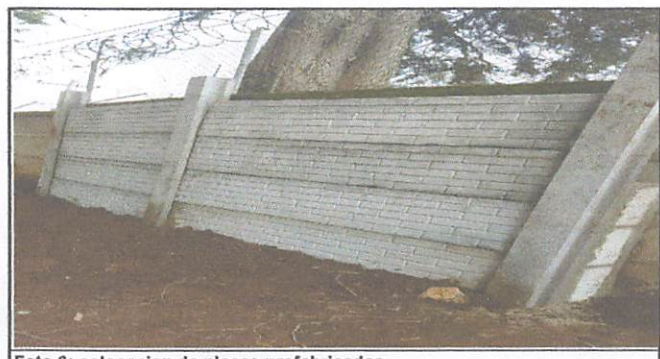
Foto 6: colocación de placas prefabricadas
