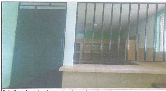
Foto 5: colocacion de puerta y baranda en la cocina
