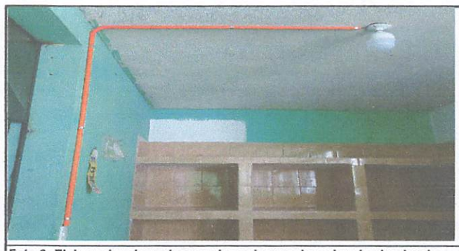
Foto 6: Elaboracion de repisas en la cocina y colocacion de alumbrado
