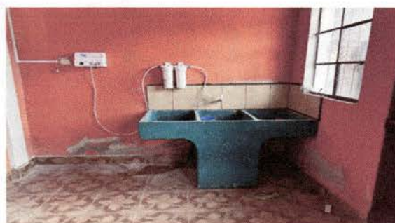
Foto 2: Quitar, colocar pila para reparar el drenaje
