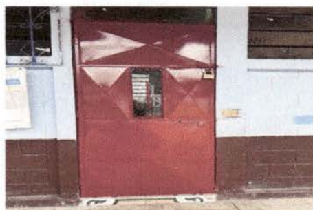
Foto 5: Mantenimiento y pintura en puertas
