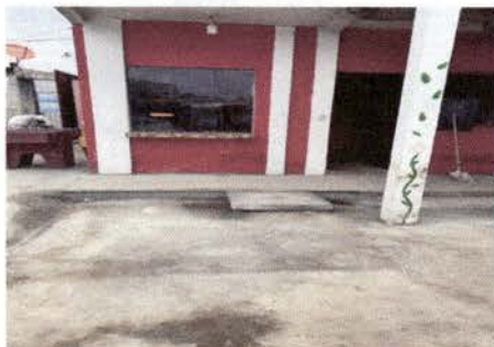
Foto 1: Fundición de una cisterna frente a la cocina
