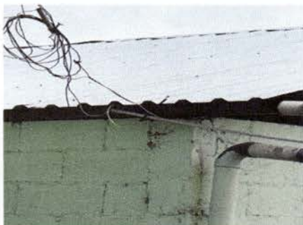
Foto 3: Cambio de lámina en los sanitarios
