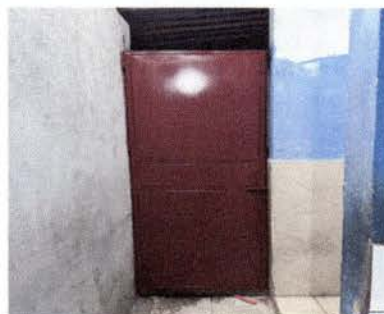
Foto 4: Elaboracion y coloccion de puerta de metal en bodega.
