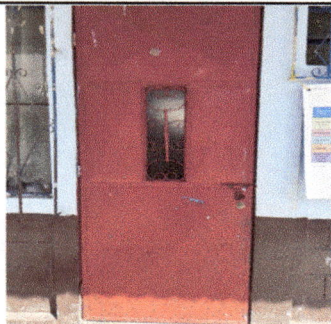
Foto 5: Mantenimiento y pintura en puertas
