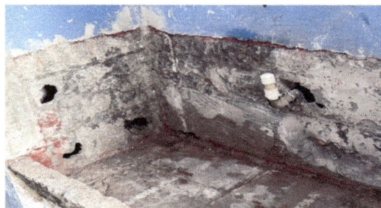
Foto 6: Remodelacion de lavamanos en sanitario de niños.
