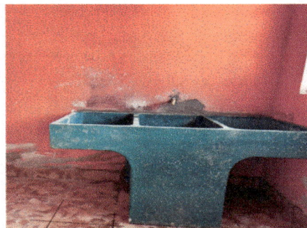
Foto 2: Quitar, colocar pila para reparar el drenaje
