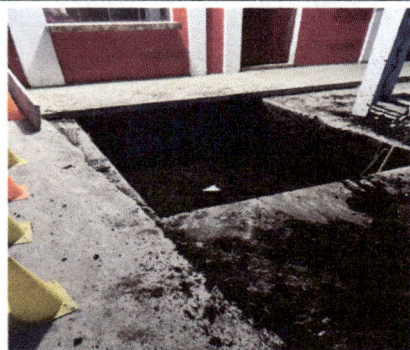
Foto 1: Fundición de una cisterna frente a la cocina
