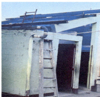
Foto 3: Cambio de lámina en los sanitarios
