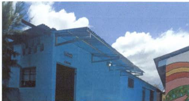
LA FOTOGRAFIA MUESTRA COMO QUEDO LA AMPLIACIÓN DEL TECHO
