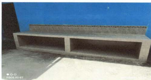
LA FOTOGRAFIA MUESTRA COMO TERMINÓ EL TOP Y MESITA DE CONCRETO PARA CUBETAS.
