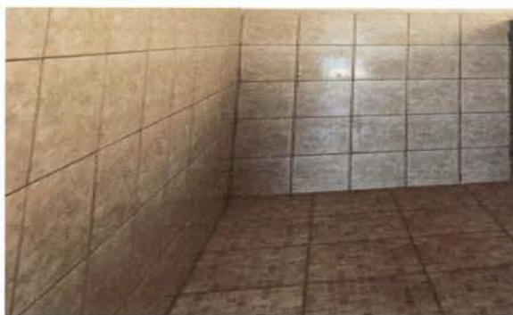
LA FOTOGRAFIA MUESTRA LAS PAREDES COLOCADO EN LOS SANITARIOS
