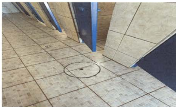
LA FOTOGRAFIA MUESTRA LA FINALIZACION DE LAS CAJAS DE REGISTRO.
