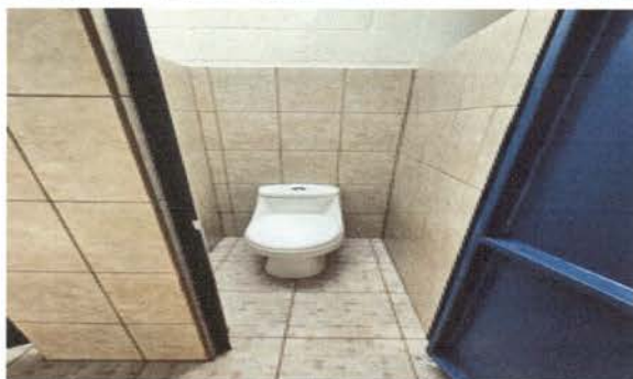
LA FOTOGRAFIA MUESTRA EL FINAL DE LOS SANITARIOS YA INSTALADOS
