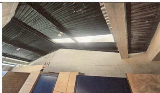
LA FOTOGRAFIA MUESTRA LOS ESPACIOS YA TERMINADOS CON SU RESPECTIVA PINTURA TANTO DENTRO DE LOS SANITARIOS COMO DE AFUERA.
