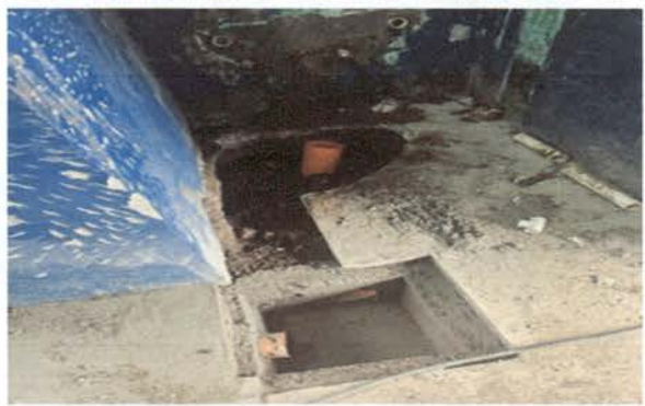
LA FOTOGRAFIA MUESTRA EL ESPACIO DE LA INSTALACION DE DRENAJE Y TUBERIA DE LOS SANITARIOS
