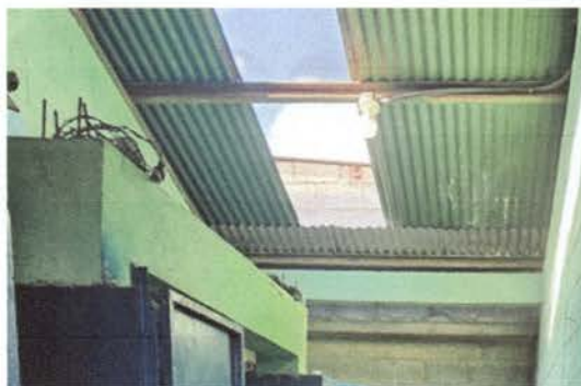
LA FOTOGRAFIA MUESTRA EL ESPACIO QUE SE UTILIZARA PARA LA LUZ NATURAL EN LOS SANITARIOS
