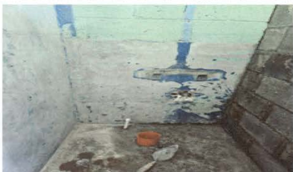
LA FOTOGRAFIA MUESTRA COMO SE HACE MEJORA LA TUBERIA PARA LA INSTALACIÓN DE SANITARIOS
