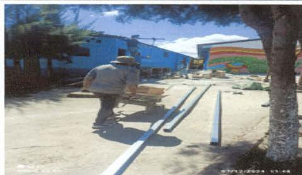
LA FOTOGRAFIA MUESTRA COMO SE VAN COLOCANDO LOS MATERIALES PARA AMPLIAR EL TECHO
