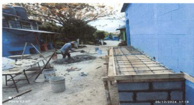
LA FOTOGRAFIA MUESTRA COMO YA ESTA INSTALADO EL HIERRO QUE SOSTENDRA LA MESA DE CONCRETO.
