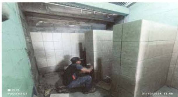
LA FOTOGRAFIA MUESTRA COMO SE PULIERON LAS PAREDES PARA PODERSE COLOCAR EL AZULEJO
