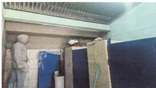
LA FOTOGRAFIA MUESTRA EL PROCESO DE REPELLO Y CERNIDO DEL FONDO DE LOS SANITARIOS
