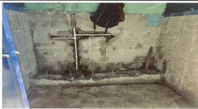
LA FOTOGRAFIA EL PROCESO DE MEJORAMIENTO DE LOS MIGITORIOS
