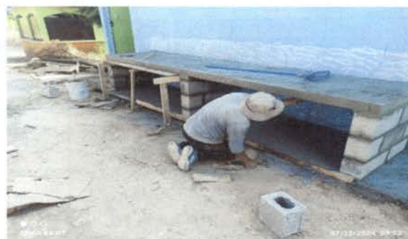
LA FOTOGRAFIA MUESTRA COMO SE VA COLOCANDO EL MATERIAL PARA LA BANQUETA.
