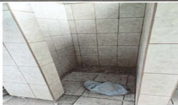
LA FOTOGRAFIA MUESTRA EL PROCESO DE COLOCACIÓN DE PISO DE LOS SANITARIOS DE NIÑOS Y DE NIÑAS
