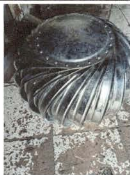
LA FOTOGRAFIA MUESTRA EL PROCESO DE ARMAR LOS EXTRACTORES PARA MEJORAR LA VENTILACION EN LOS SALONES
