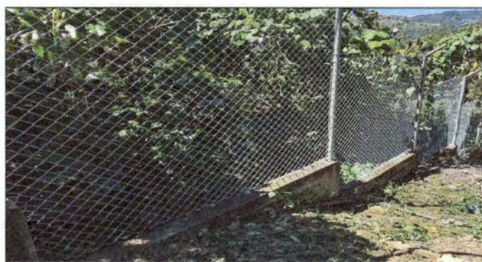
Foto 6: Cambio de malla del muro perimetral.
