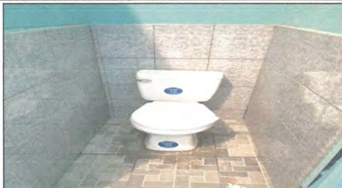
Foto1: Cambio de inodoros y lavamanos con pedestal.
