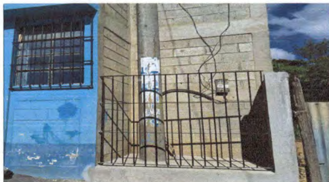
Foto 4: Levantado de muro y fundición de banqueteta y colocación de baranda.
