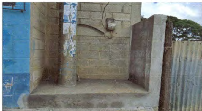
Foto 4: Levantado de muro y fundición de banquetta y colocación de baranda.
