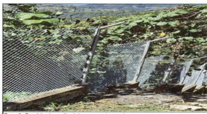
Foto 6: Cambio de malla del muro perimetral.
