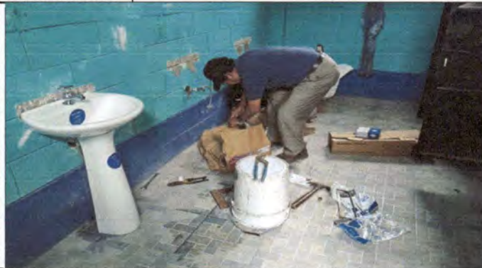
Foto 1: Cambio de inodoros y lavamanos con pedestal.
