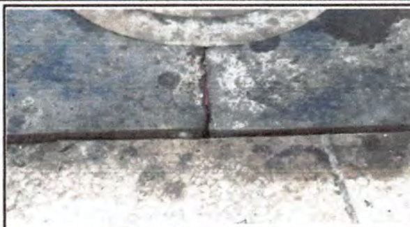
Foto 2: Plancha de metal rajada y torcida
