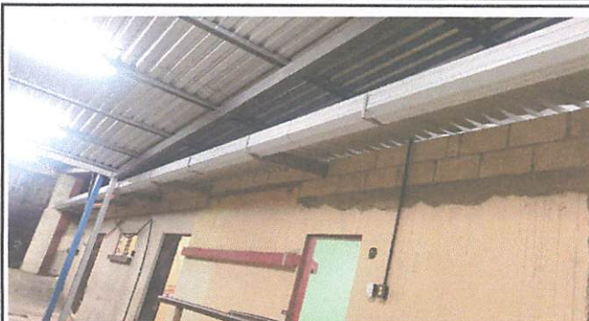
Foto 2: Tejado del salón y bodega de Educación Física
